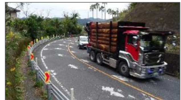
写真① 道路線形が厳しい区間
