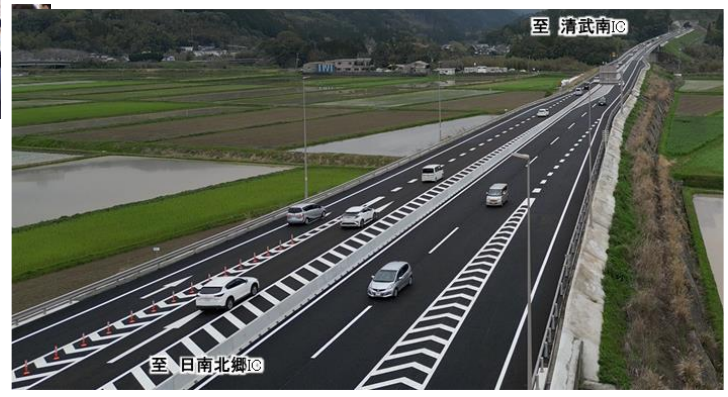
▲開通後の状況 (日南北郷ICから清武南IC方面を望む)
